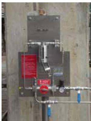
Il nuovo Recovery System di Dopak, permette il recupero totale del campione prelevato in eccesso, reinserendolo ove desiderato, all'interno del ciclo produttivo, e la bonifica completa della bottiglia di prelievo, rendendola riutilizzabile per successivi campionamenti.
